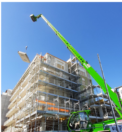
Fase di taglio e rimozione dei balconi esistenti deteriorati.
