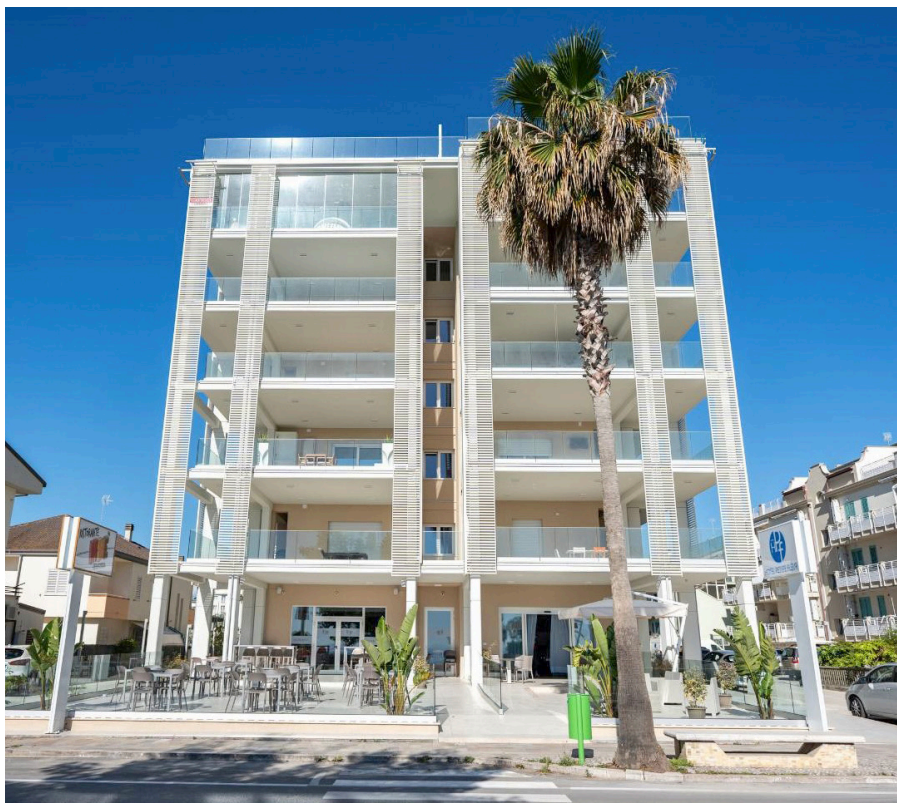
Il condominio "Petit Fleur", sito in Alba Adriatica (TE), dopo i lavori di miglioramento sismico ed efficientamento energetico del fabbricato, prospetto est (fronte mare).
