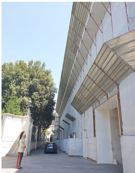
Una facciata interna del Compendio del Quirinale durante l'intervento di restauro.
