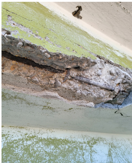
Strutture in c.a. esistenti danneggiate e degradate a causa dell'azione di ossidazione delle barre d'armatura con la conseguente espulsione del copriferro.
