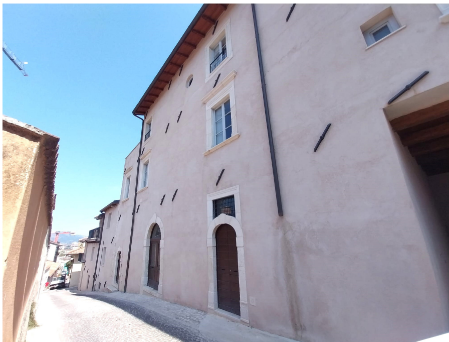
Aggregato Pretatti-Loddi, vista del fabbricato su via Pretatti dopo i lavori di riparazione con miglioramento sismico.
