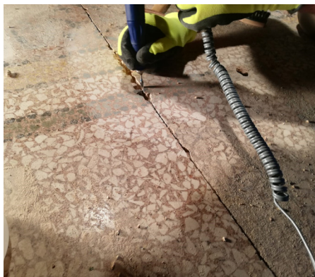
Durante i lavori.
