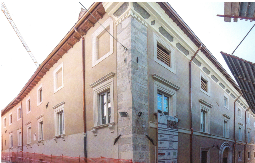
Fasi conclusive dei lavori all'aggregato Chiarizia De Marinis, L'Aquila.
