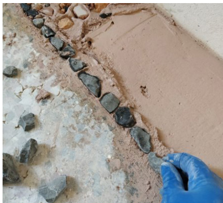
Durante i lavori.
