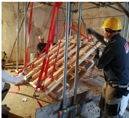
Operazioni di distacco e movimentazione degli elementi catalogati.
