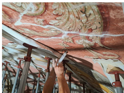
Consolidamento degli intonaci tramite iniezioni.
