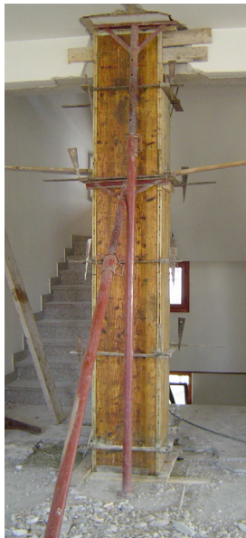
Rinforzo di pilastri in c.a. con placcaggio di confinamento in acciaio.
