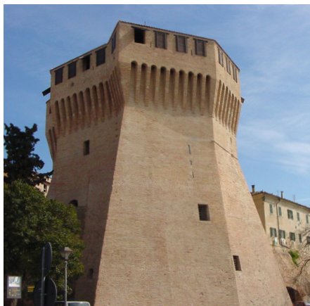
Rocca di Mondavio, Pesaro - Urbino. Il mastio dopo i lavori di consolidamento e restauro.
