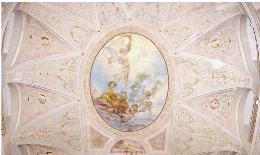
Teatro "La Fenice" di Amandola, Fermo. La volta della platea dopo il restauro.
