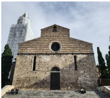
Cattedrale di Santa Maria Assunta, Teramo, prima e durante i lavori di miglioramento sismico e restauro.
