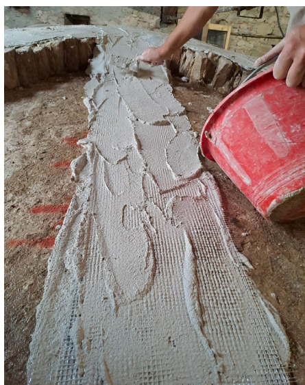
Consolidamento delle volte a crociera mediante fasciatura con fibra di acciaio.
