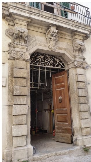
Il portale di ingresso al palazzo Alfieri-Galli prima dei lavori.
