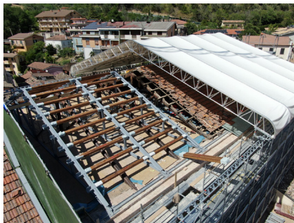
Fasi di montaggio della nuova copertura con travi reticolari metalliche e travi in castagno, con sovrastante copertura provvisoria in lega leggera scorrevole sui binari a salvaguardia delle infiltrazioni di acqua durante le fasi lavorative.
