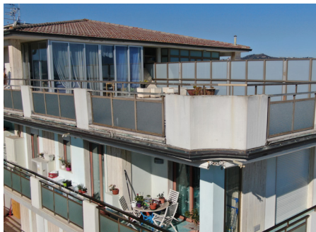
L'angolo sud-est del condominio prima e dopo i lavori.
