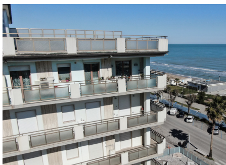
Vista sud del condominio prima e dopo i lavori.
