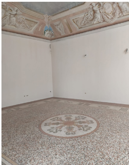
Presentazione estetica del seminato alla veneziana riassembleto a fine lavori.
