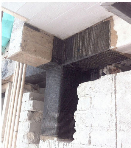
Condominio "Vecchia Posta", L'Aquila. Applicazione di fibra di carbonio ai nodi trave-pilastro.
