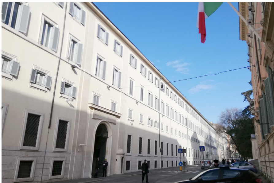
Una delle facciate esterne del Compendio del Quirinale dopo l'intervento di restauro.
