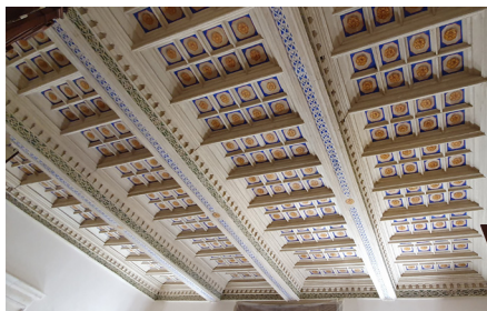
Cassettonato ligneo restaurato - Palazzo Chiarizia De Marinis, L'Aquila.
