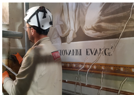
Consolidamento degli intonaci tramite stuccature delle lesioni.
