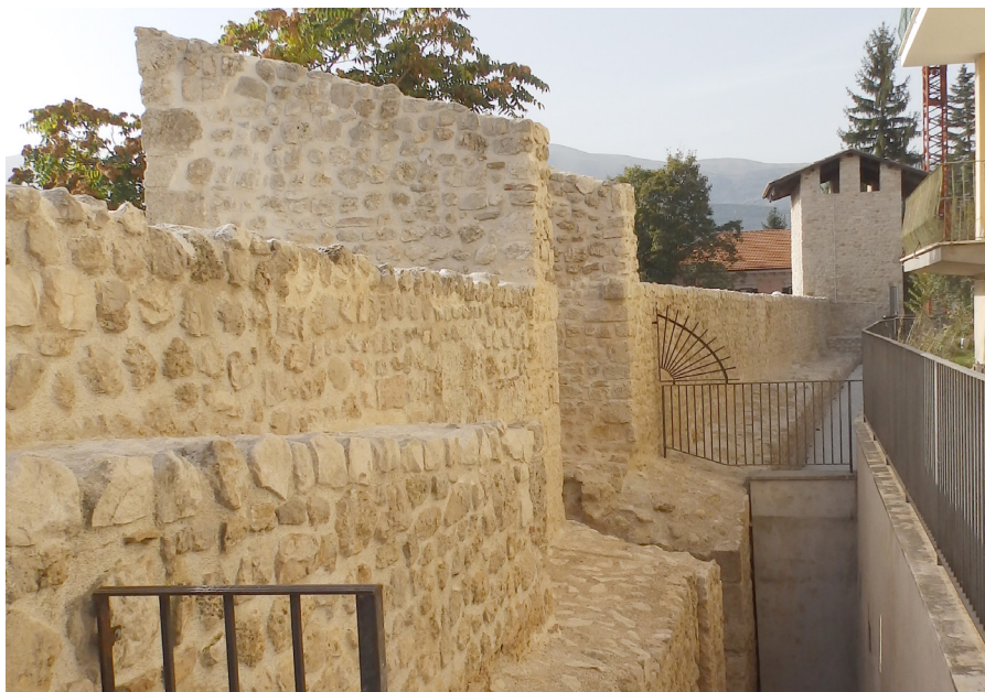
Le Mura Civiche di L'Aquila dopo i lavori.
