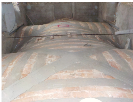
Aggregato n.478 S.Giusta, Via Cimino, L'Aquila. Realizzazione consolidamento volta a crociera mediante fasciatura con fibra di acciaio.
