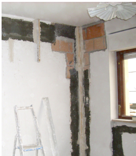
Condominio "Vecchia Posta", L'Aquila. Applicazione di fibra di carbonio ai nodi trave-pilastro.
