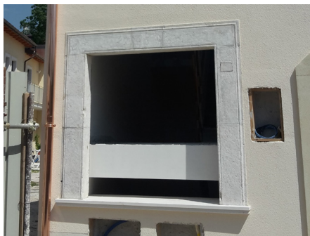
Rimontaggio degli imbotti in pietra originali.
