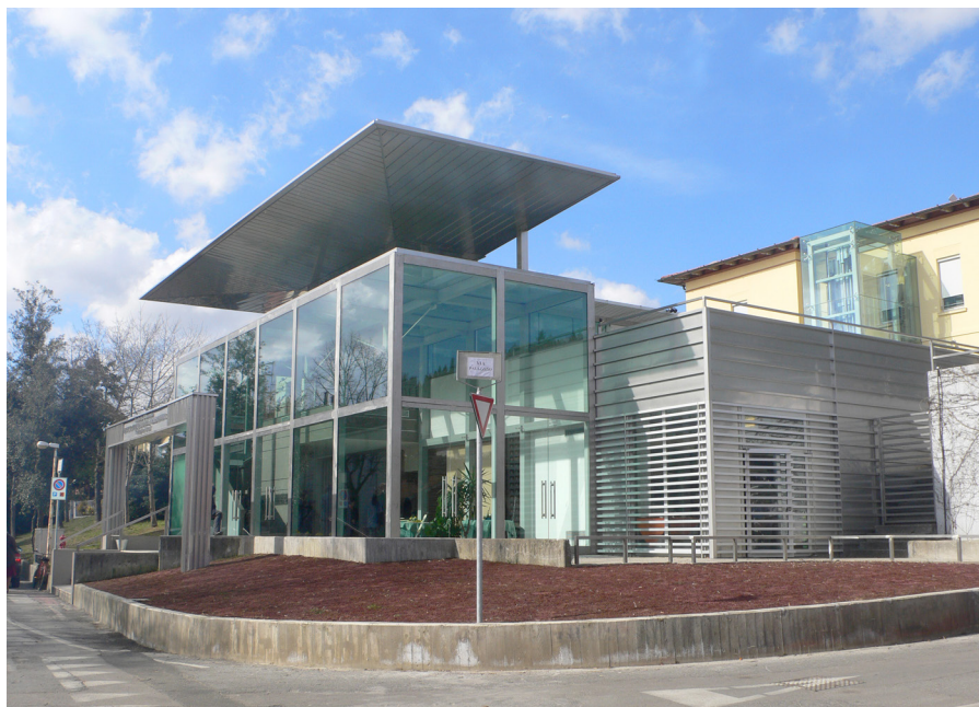
Istituto Professionale Alberghiero "P. Artusi", Riolo Terme, Ravenna. La struttura d'ingresso in acciaio e vetro dopo i lavori.
