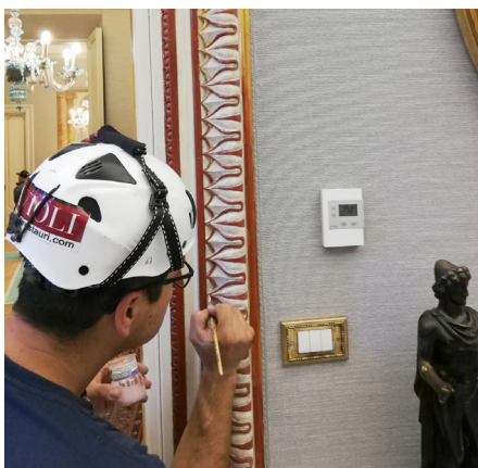
Fasi di restauro degli interni del Quirinale.
