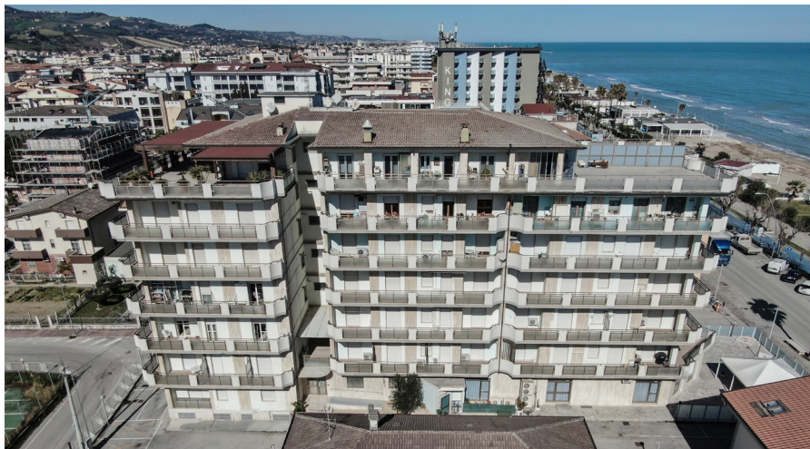
Il condominio "Petit Fleur", prima dei lavori di miglioramento sismico ed efficientamento energetico del fabbricato, prospetto sud.
