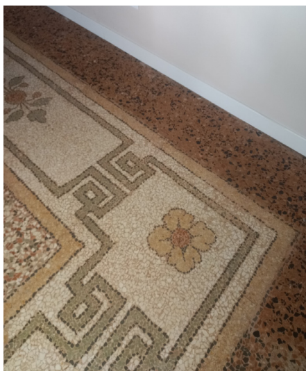
Un dettaglio del seminato dopo i lavori di restauro.
