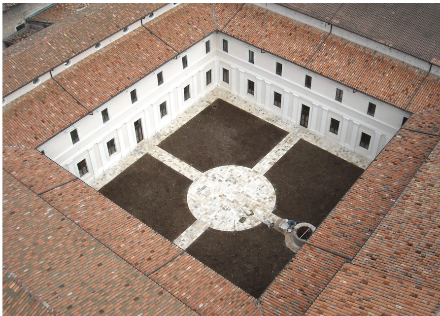
Veduta aerea del convento di San Domenico di L'Aquila al termine dei lavori svolti in ati.
