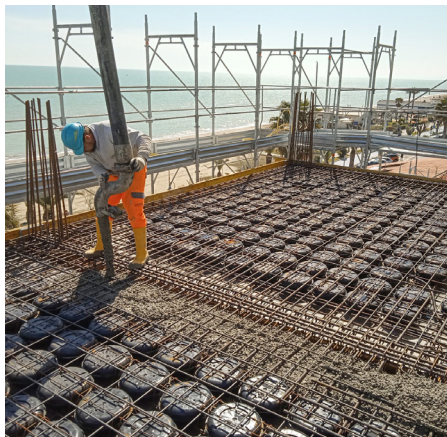
Fase di getto dei nuovi solai dei balconi delle torri dissipative.
