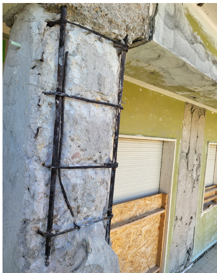
Strutture in c.a. esistenti danneggiate e degradate a causa dell'azione di ossidazione delle barre d'armatura con la conseguente espulsione del copriferro.
