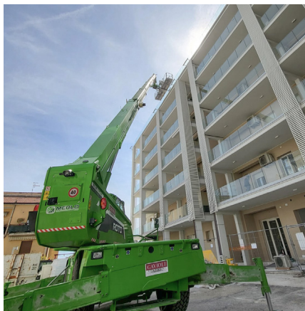
Installazione dei proiettori illuminanti con l'ausilio della piattaforma telescopica con braccio da 35 metri.
