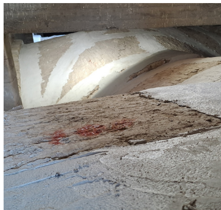
Consolidamento delle volte.
