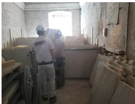
Deposito delle porzioni di seminato alla veneziana distaccate e consolidate.
