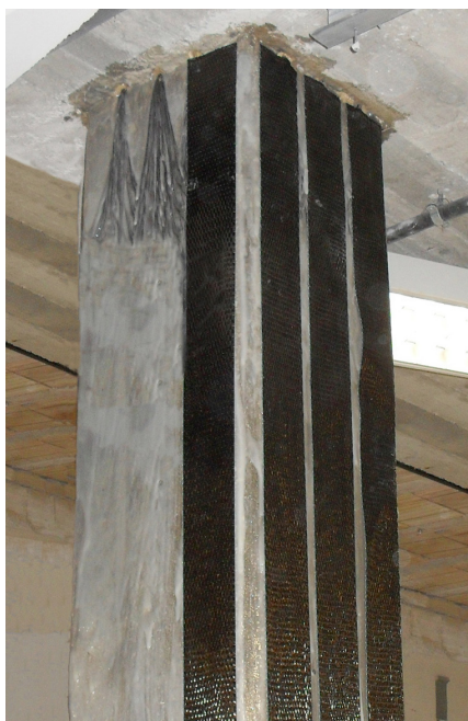
Posa in opera della fibra in carbonio sull'intera sezione del pilastro con l'utilizzo di resine epossidiche.
