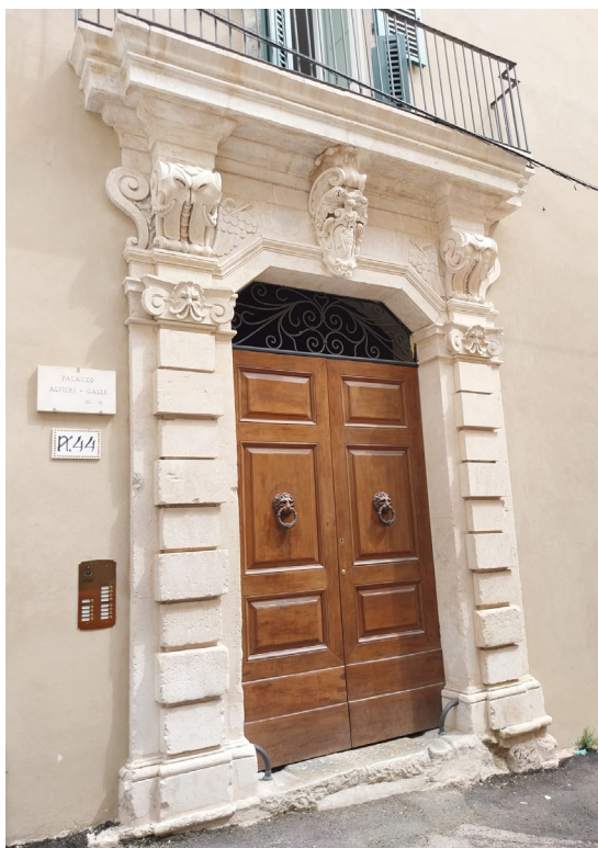
Il portale di ingresso al palazzo Alfieri-Galli dopo i lavori.
