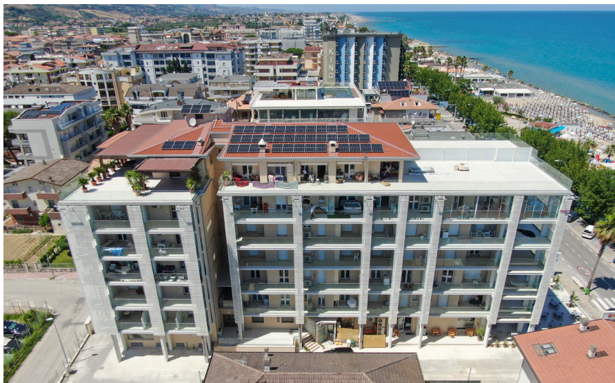
Il condominio "Petit Fleur", dopo i lavori di miglioramento sismico ed efficientamento energetico del fabbricato, prospetto sud.
