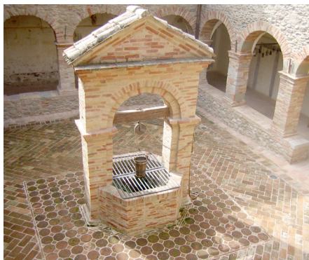
Chiostrò dell'ex-convento degli Zoccolanti di Montorio al Vomano, Teramo, dopo i lavori.
