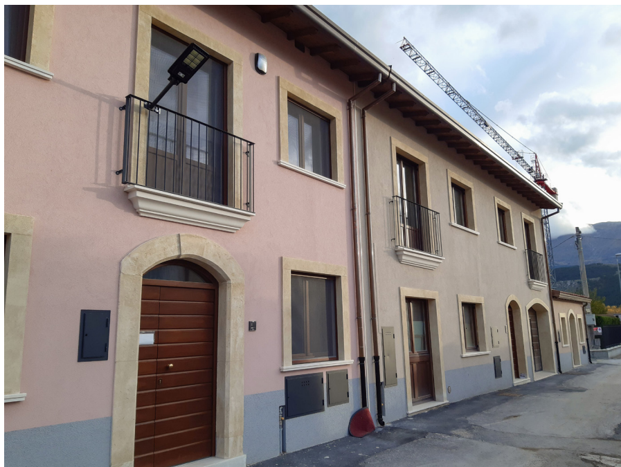
Parte del fabbricato a conclusione dei lavori, da notare il recupero degli elementi lapidei originali.
