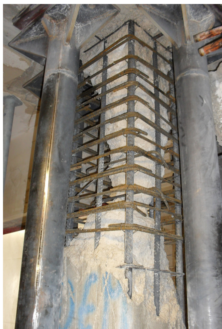
Pulizia e passivazione delle armature messe a nudo, integrazione delle armature esistenti.
