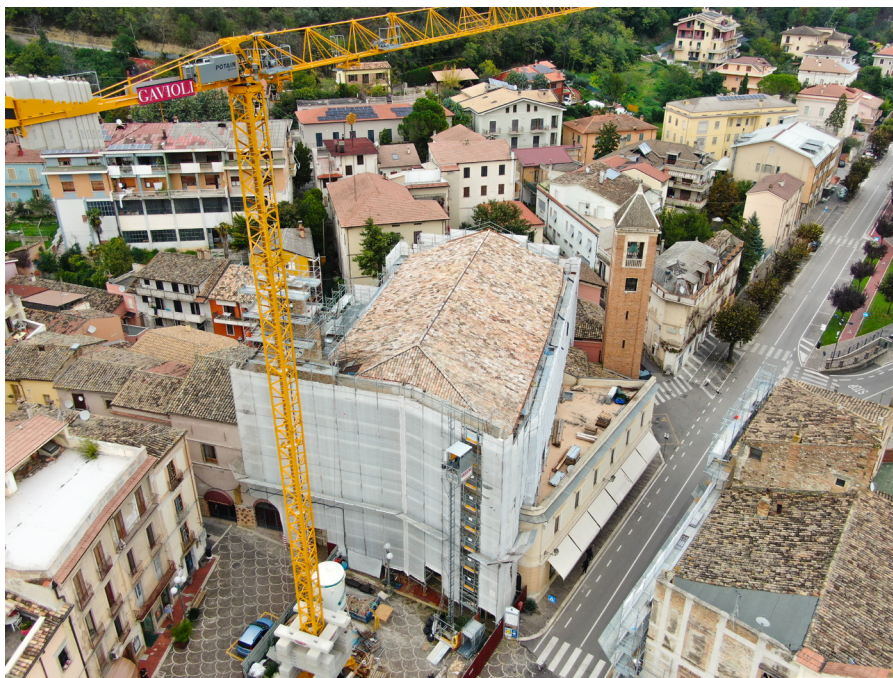
Collegiata di San Rocco, Montorio al Vomano (TE), veduta aerea del cantiere dopo la realizzazione della nuova copertura.
