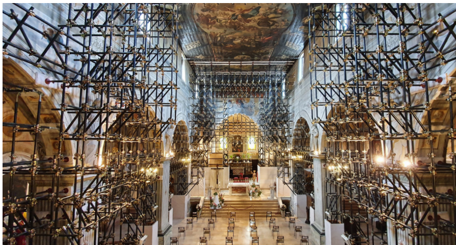
L'interno della chiesa durante i lavori.
