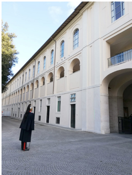
La stessa facciata dopo l'intervento.
