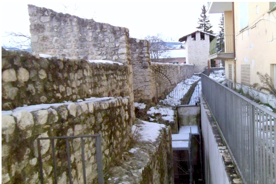
Le Mura Civiche di L'Aquila prima dei lavori.
