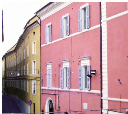
Il Palazzo Comunale di Fabriano dopo i lavori di restauro.
