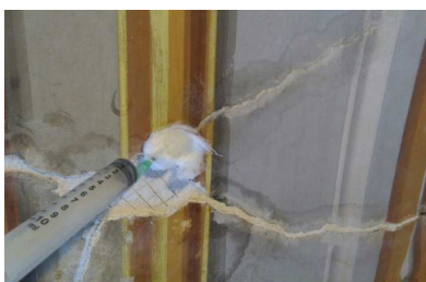
Consolidamento di profondità della superficie pittorica.
