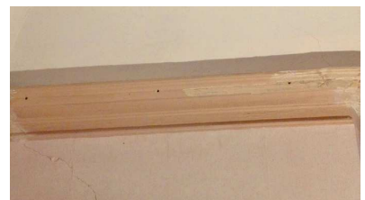
Perfori lungo la cornice.
