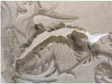
Stuccatura di una lesione della superficie pittorica.
