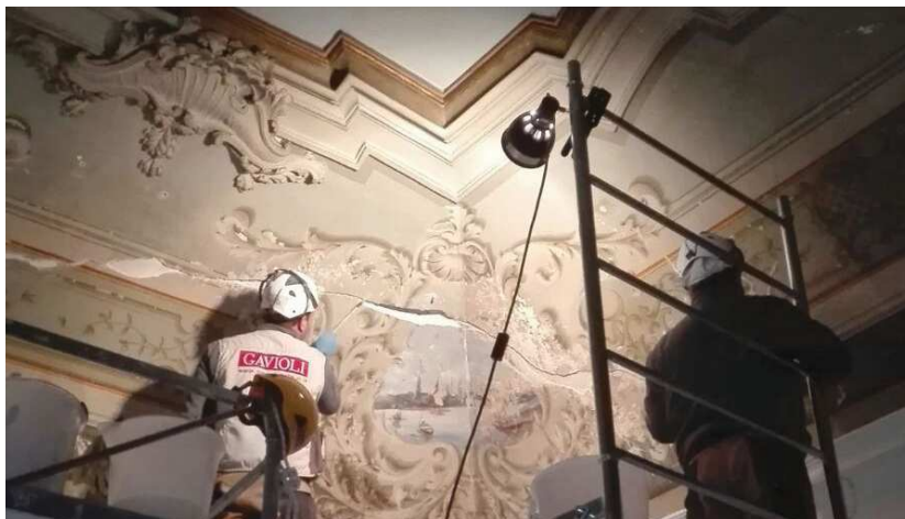
Fasi di consolidamento della pellicola pittorica.
