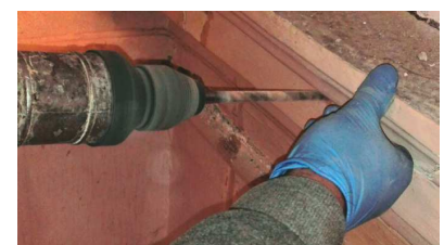
Perforo per la posa del connettore.
