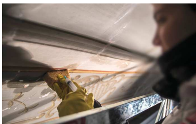
Fasi di consolidamento della pellicola pittorica.
