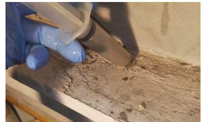
Consolidamento di profondità degli stucchi.
