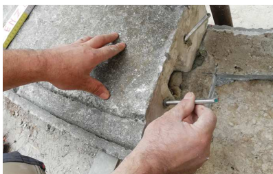
Inserimento di connessioni meccaniche tra elementi marmorei adiacenti.
