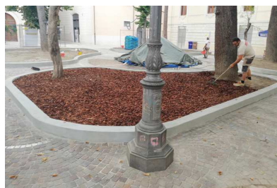
Le aiuole dopo i lavori.
