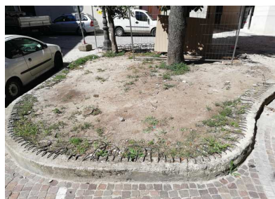
Stato di degrado delle aiuole.
