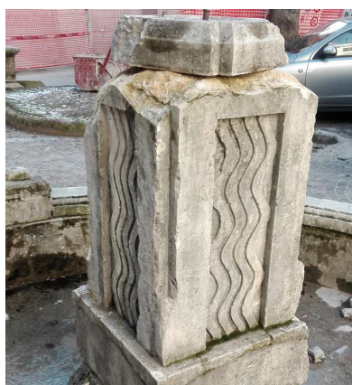
L'evidente degrado materico prima dei lavori.
