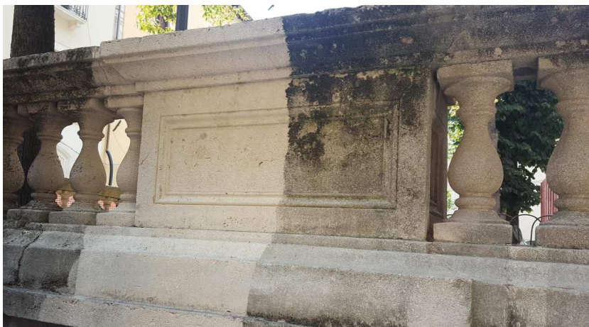
Particolare della balaustra, differenza tra prima e dopo la pulitura.
