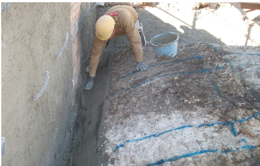
Fasi di consolidamento estradosale.
