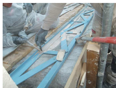
Particolare dell'inghisaggio dei cordoli sommitali.
