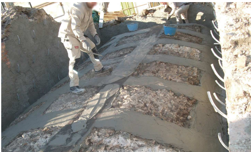
Consolidamento mediante applicazione di fibra di basalto.
