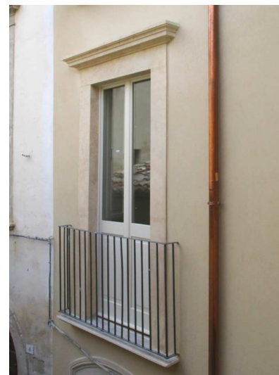
Prospetto a lavori ultimati.
