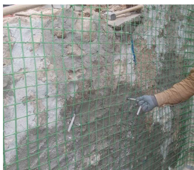
Consolidamento pareti mediante fibra di vetro ancorata alla muratura.
