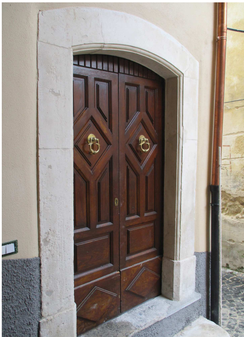
Uno degli infissi storici dopo il restauro.
