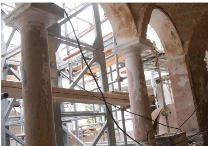
Il chiostro interno prima dei lavori.
