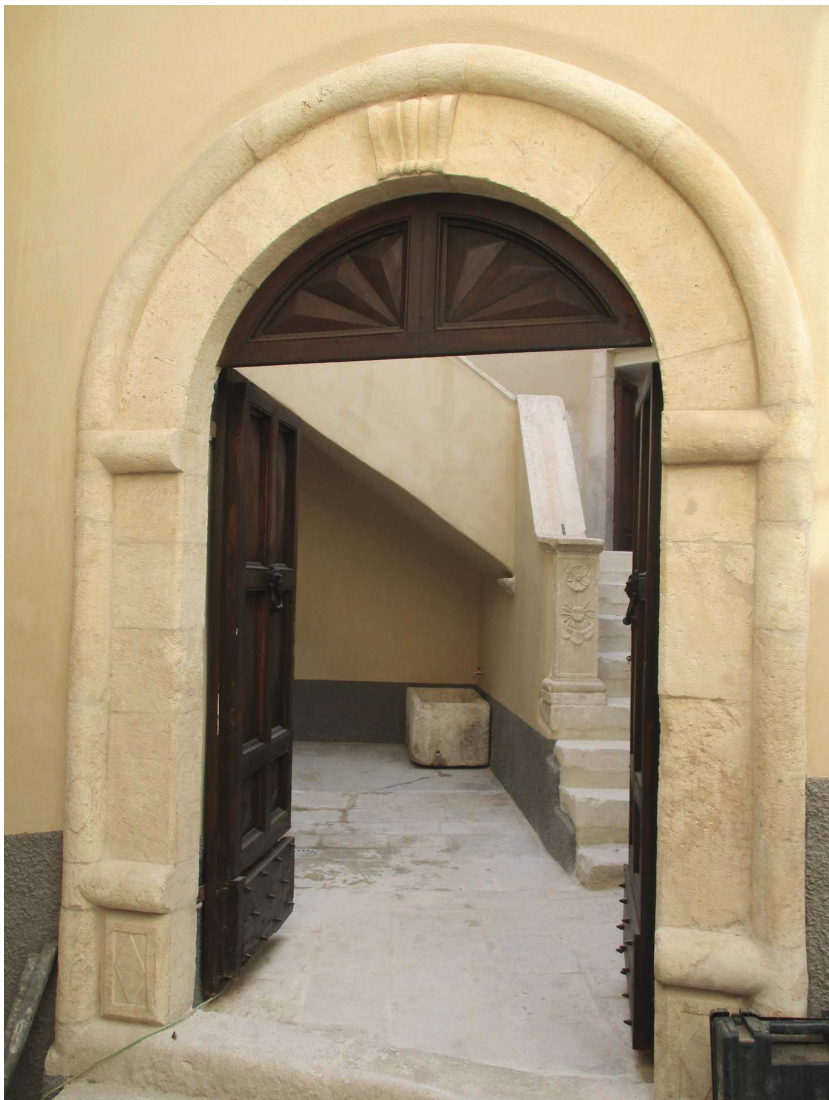
Il portale principale dopo i lavori.
