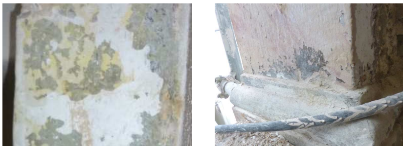
Dettagli di scialbature a calce e cementizie.
