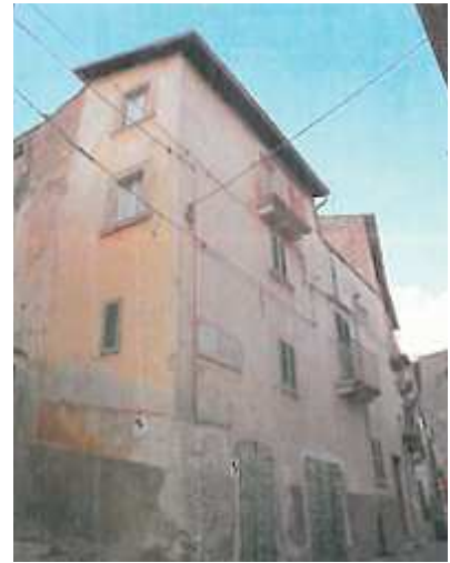
Prospetto angolo via Moscardelli - Piazza Dante prima dei lavori.
