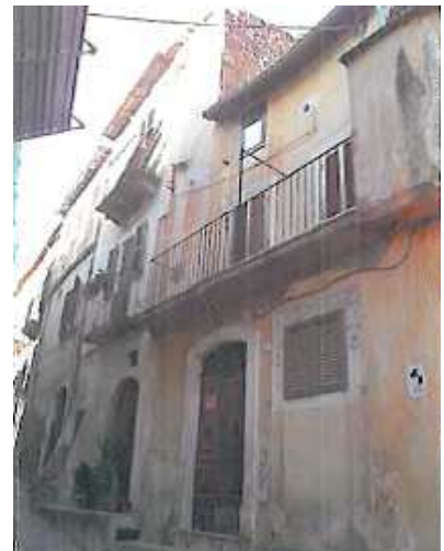
Prospetto via XX Settembre prima dei lavori.
