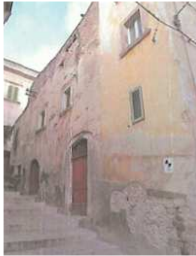
Prospetto via Moscardelli prima dei lavori.
