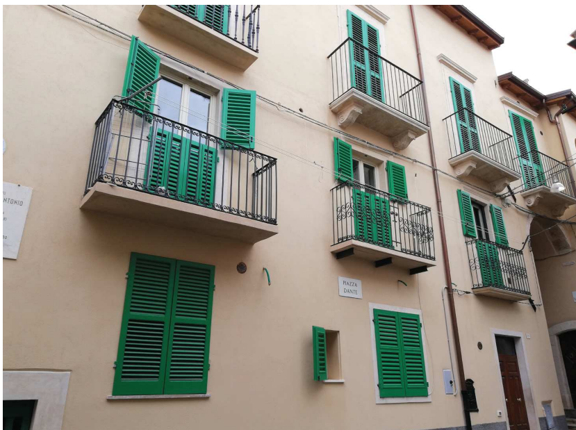
Prospetto via XX Settembre a lavori ultimati.
