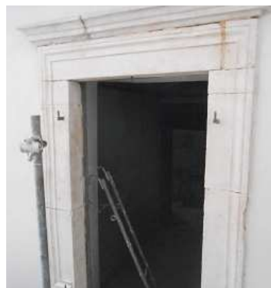
Elementi lapidei costituiti da colonne, portali e imbotti.
