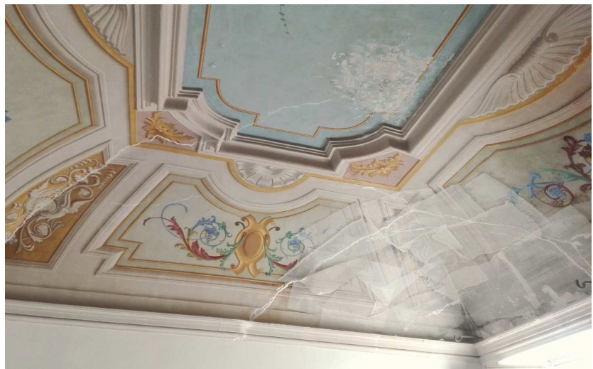
Consolidamento e messa in sicurezza mediante l'applicazione di velatino di garza e stuccatura delle fessurazioni.
