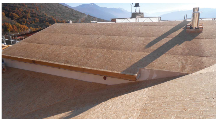
Fasi di ultimazione delle coperture in legno.
