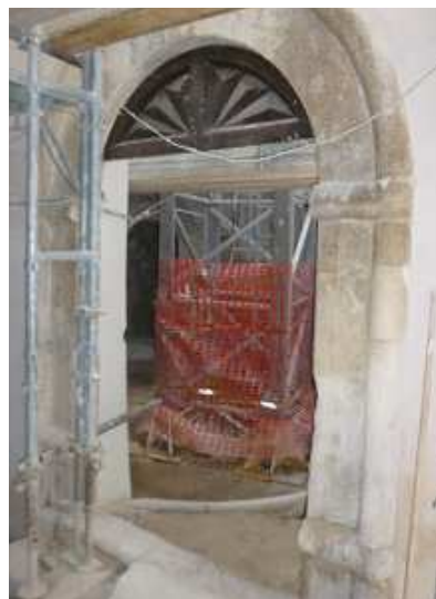
Il portale principale prima dei lavori.
