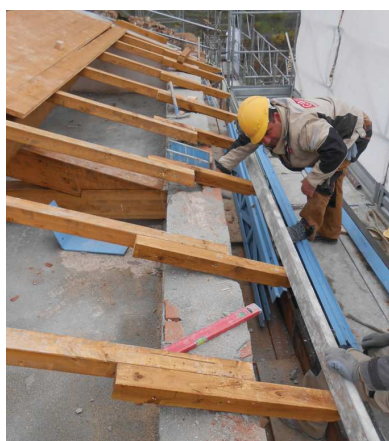
Interventi sulle coperture.
