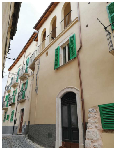
Facciata al termine dei lavori.
