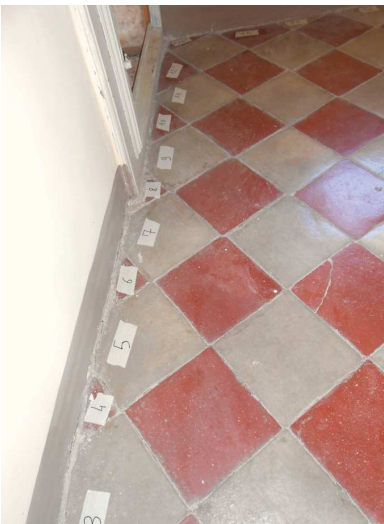
Marcatura pezzi speciali del pavimento originale.
