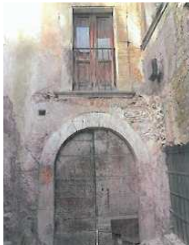
Prospetto via degli Archi prima dei lavori.
