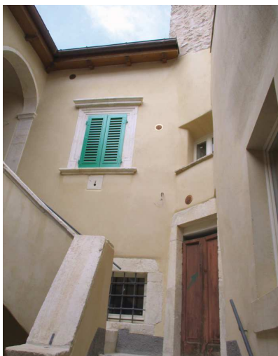
Il chiostro interno a lavori ultimati.
