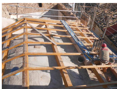
Primi interventi sulle coperture.
