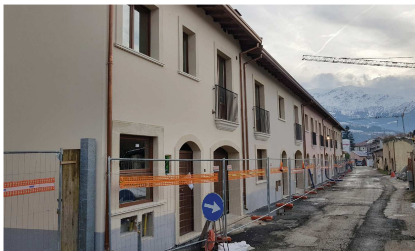
Fasi finali dei lavori.
