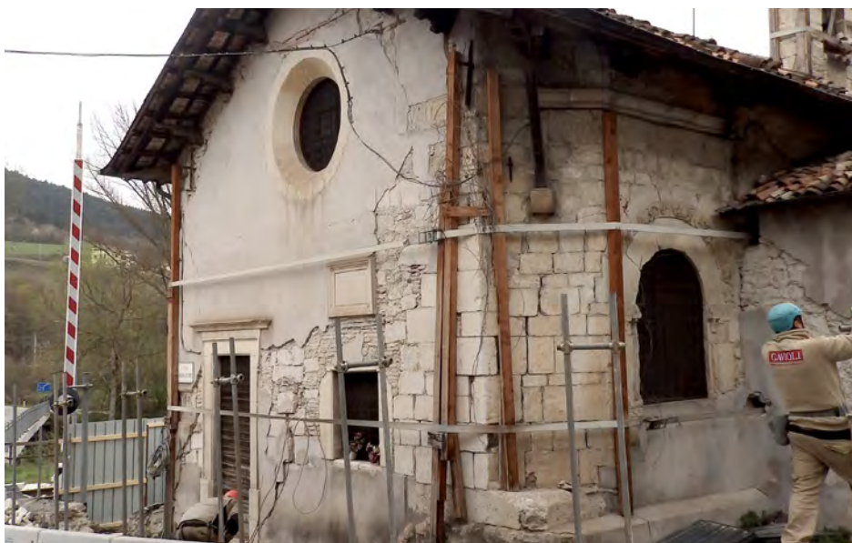
La chiesa prima dei lavori.
