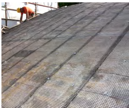
Intervento di consolidamento pianellato.
