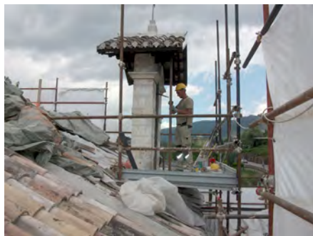
Fasi del consolidamento del campanile.
