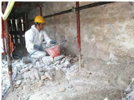
Particolare delle fasi di consolidamento.
