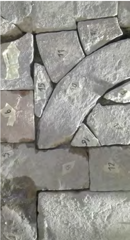
Ricollocazione degli elementi lapidei catalogati.
