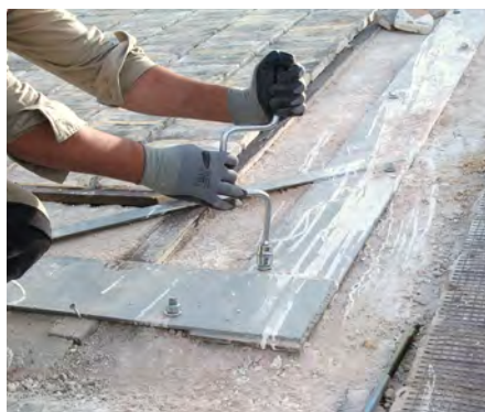
Realizzazione cordolatura metallica.
