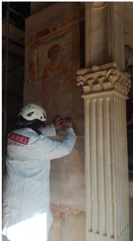
Rilievo delle sagome per consentire la successiva ricollocazione dei frammenti.
