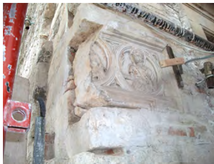
Dettaglio durante i lavori.
