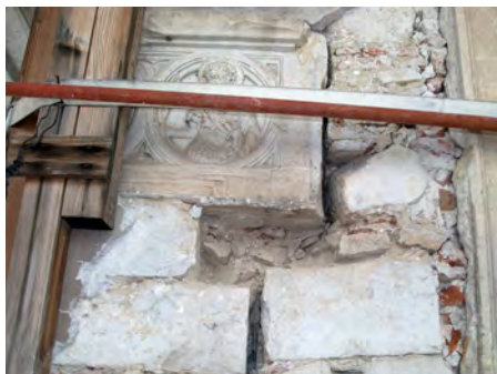
Dettaglio prima dei lavori.
