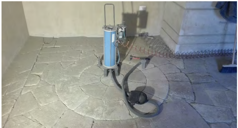
Lavori di restauro della pavimentazione in marmi policromi.
