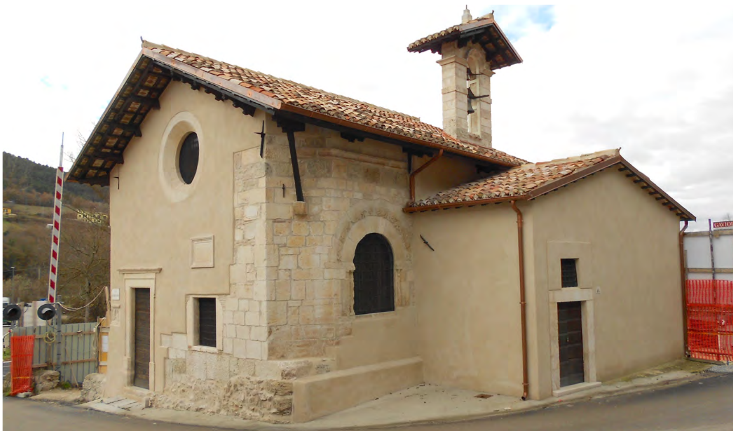
La chiesa a lavori ultimati.
