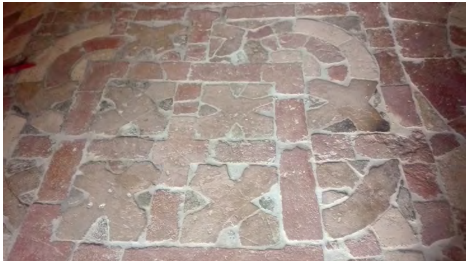
La pavimentazione in marmi policromi al termine dei lavori.
