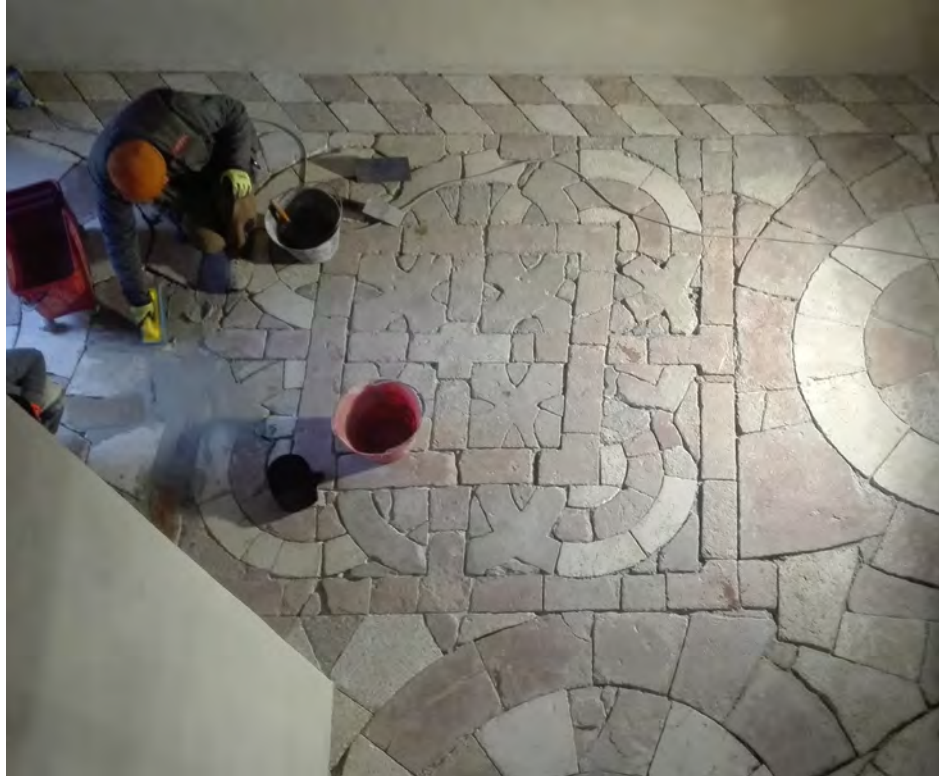
La pavimentazione in marmi policromi durante i lavori.
