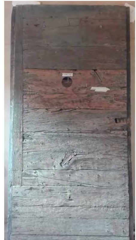
Il portone principale prima del restauro.
