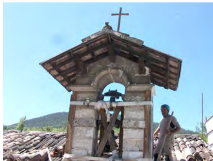
Il campanile all'inizio dei lavori.
