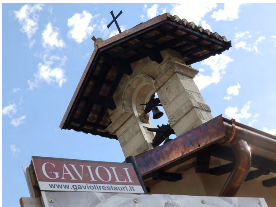
Il campanile al termine dei lavori.
