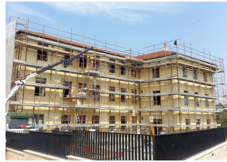
L'edificio durante i lavori.
