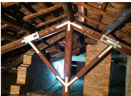
Consolidamento alla copertura in legno.
