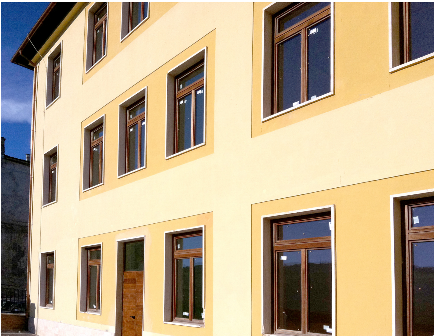
La facciata a lavori ultimati.
