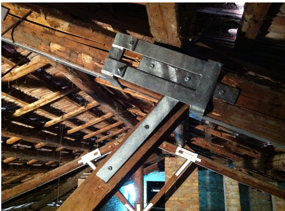
Consolidamento solai con sottostruttura in acciaio.
