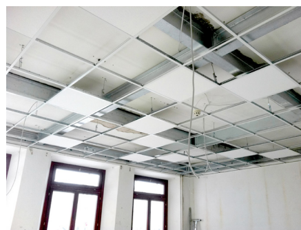
Interni durante i lavori.
