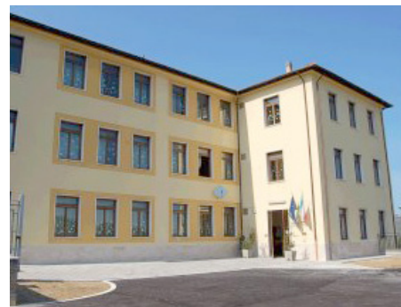
La facciata a lavori ultimati.
