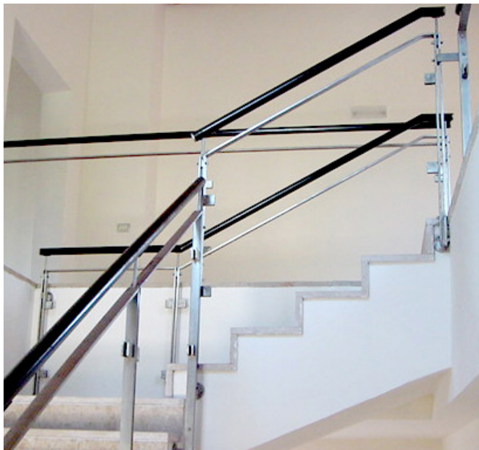
In questa pagina: varie foto a lavori ultimati.
