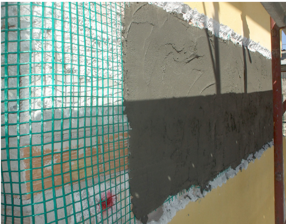
Applicazione della rete in fibra di vetro.
