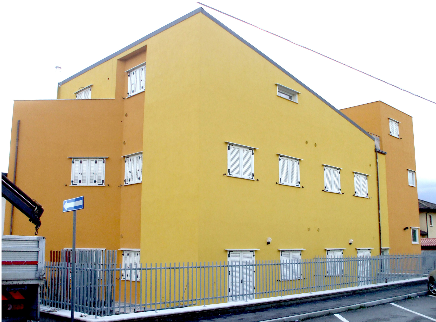
Il fabbricato a lavori ultimati.
