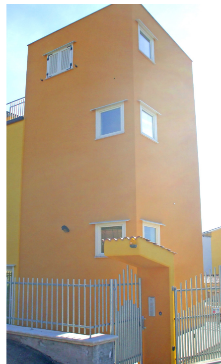
Dettaglio del fabbricato a lavori ultimati.
