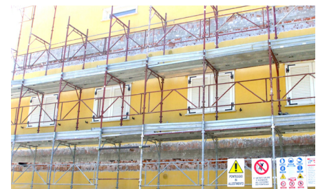
Durante i lavori.
