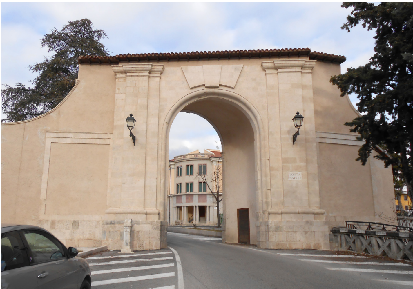
Porta Napoli, vista generale a lavori ultimati.
