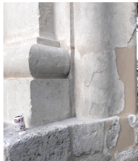
Particolare dopo i lavori di restauro.
