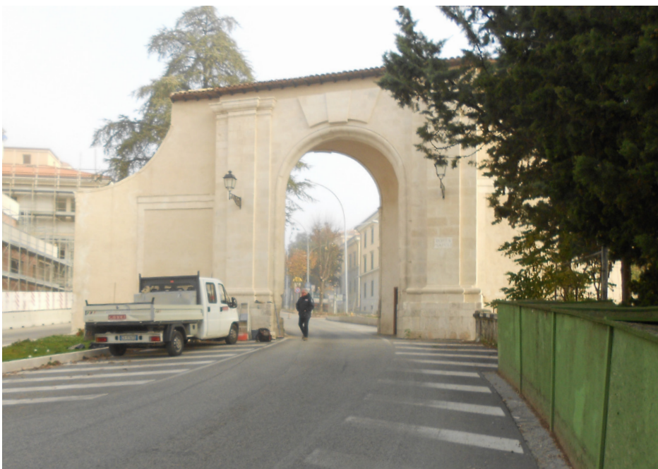
Porta Napoli dopo i lavori.
