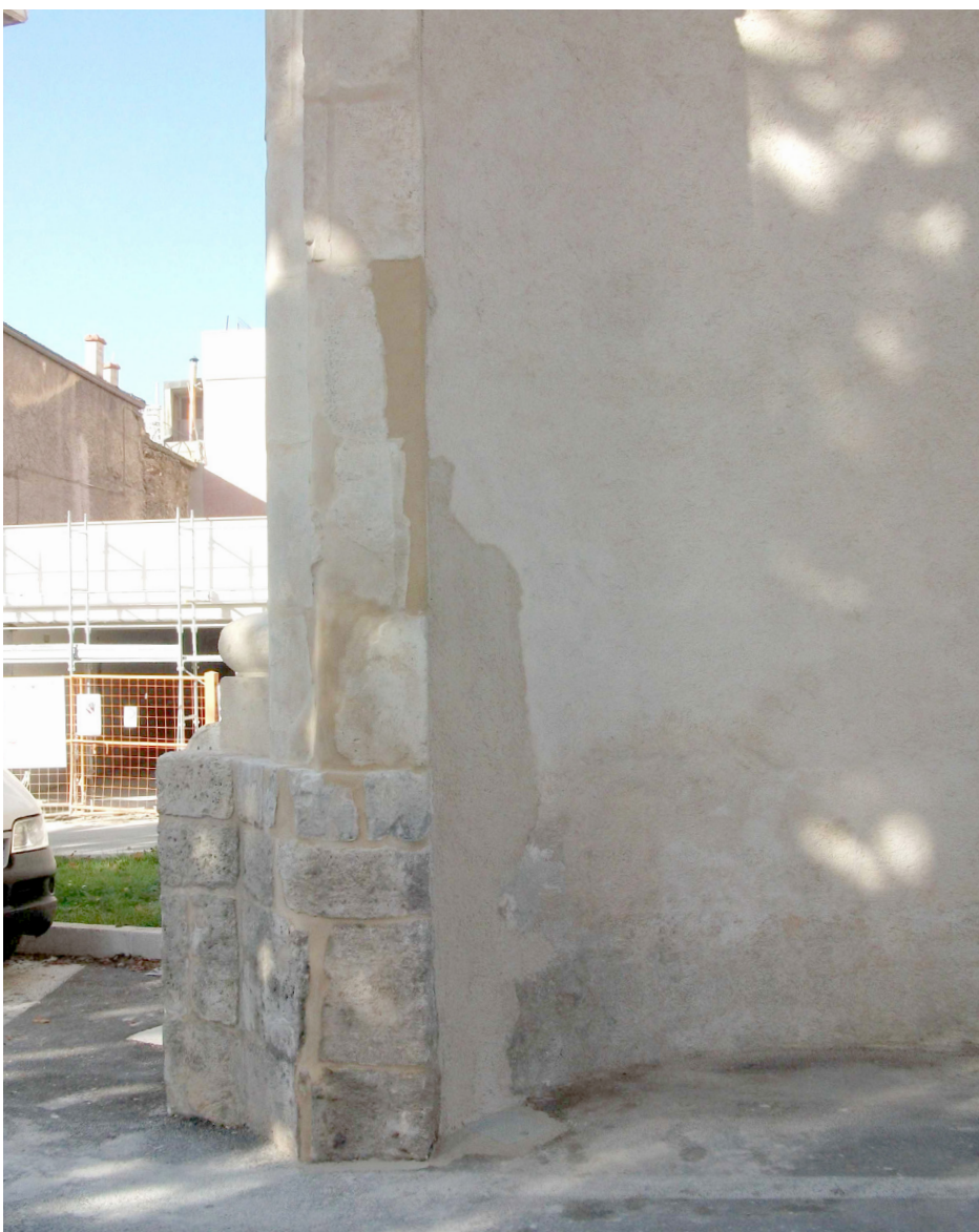
Particolare degli elementi lapidei dopo i lavori di restauro.
