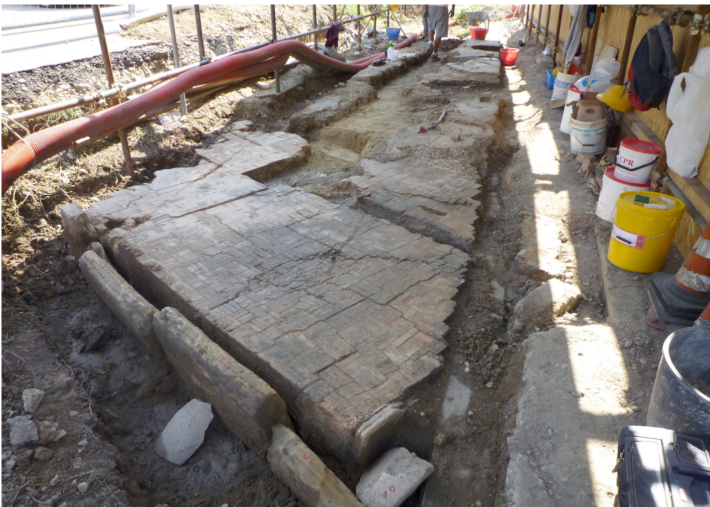
Varie fasi di scavo e di restauro.
