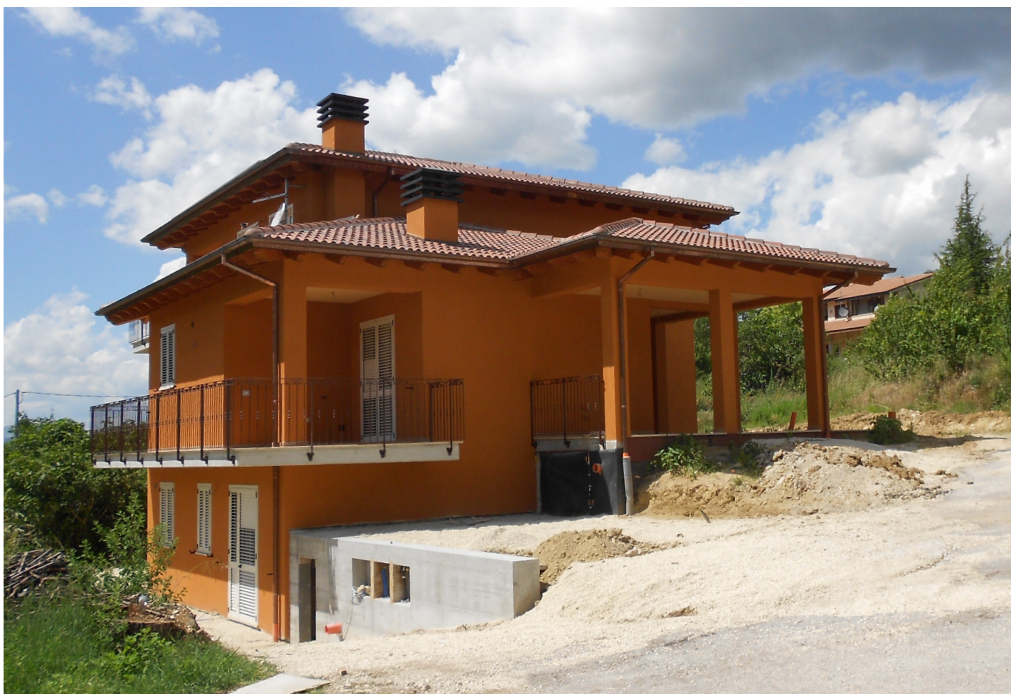
Fasi terminali dei lavori.
