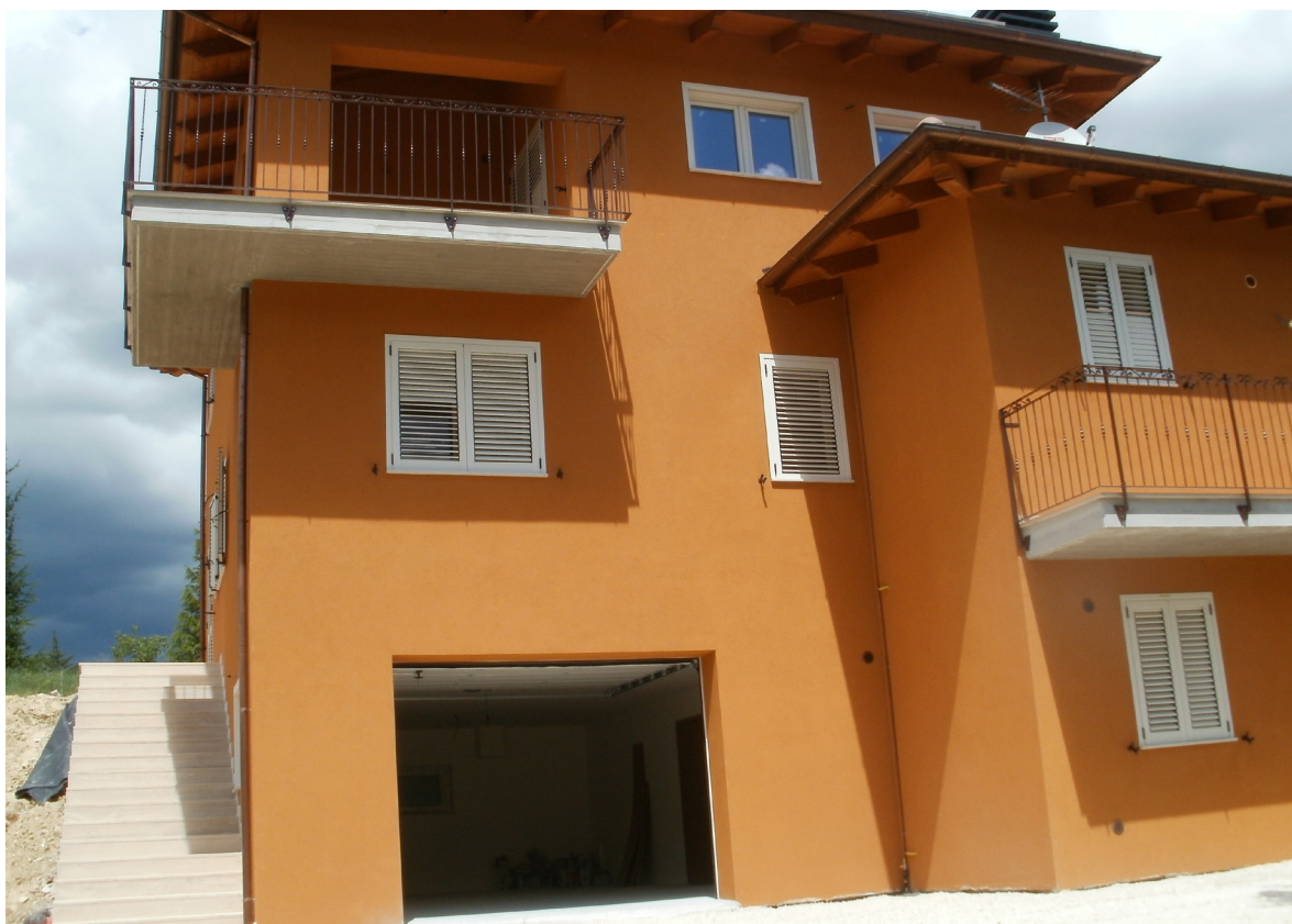
Fasi terminali dei lavori.
