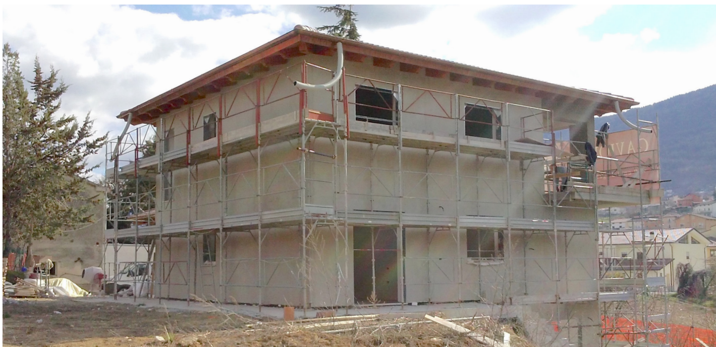
Durante i lavori.
