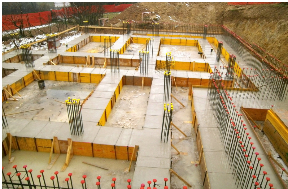
Durante i lavori.
