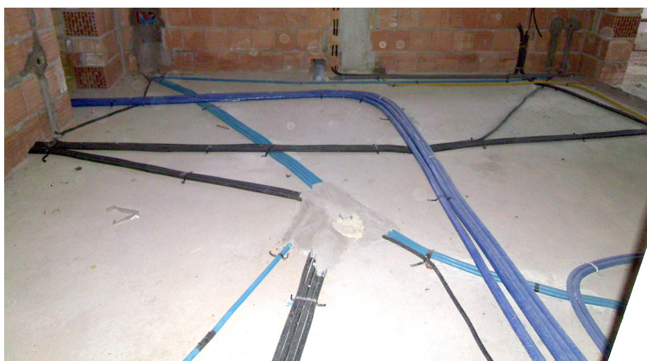
I nuovi impianti durante i lavori.
