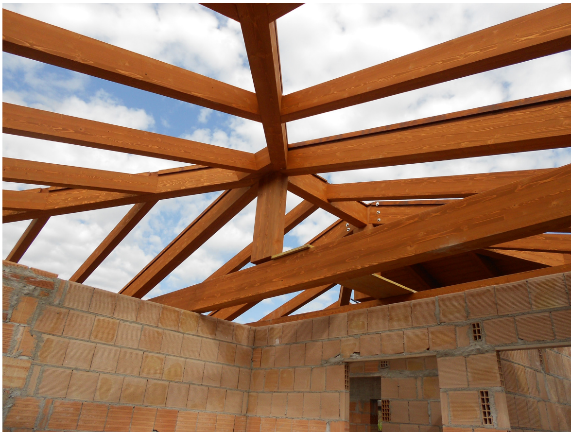
Realizzazione della copertura.
