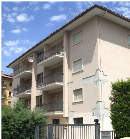
Il condominio prima dei lavori.
