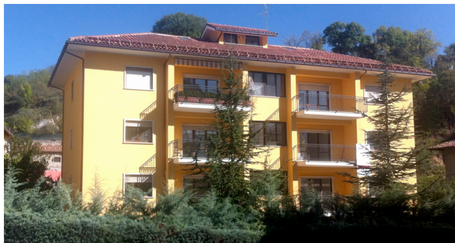
Il palazzo a lavori ultimati.
