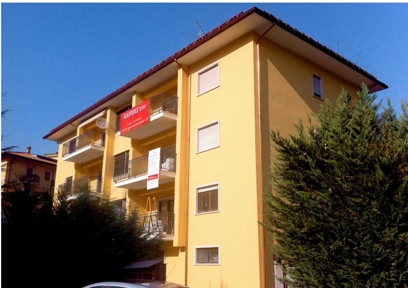
Il condominio a lavori ultimati.
