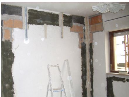
Fasi di applicazione di fibra di carbonio.
