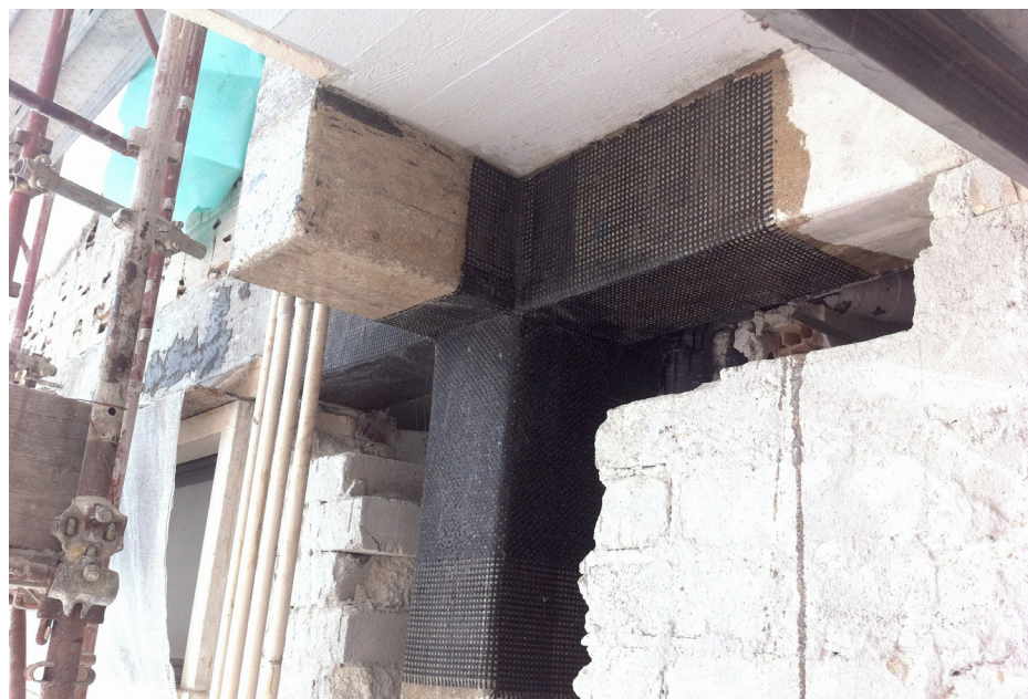
Applicazione di fibra di carbonio ai nodi trave-pilastro.
