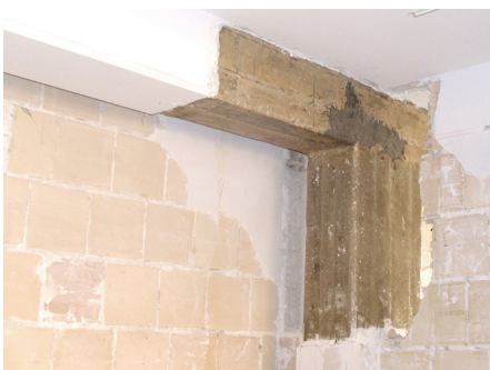
Fasi di applicazione di fibra di carbonio.
