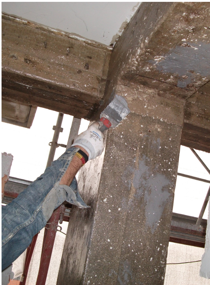
Trattamento per il rinforzo dei nodi trave-pilastro.
