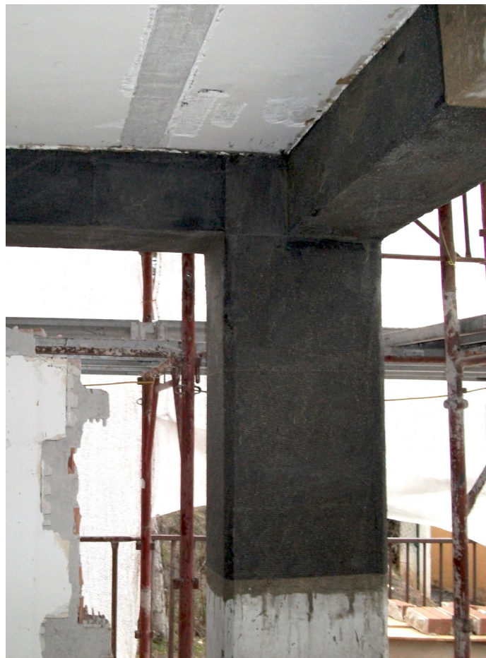
Sovrapposizione grafica degli interventi effettuati sui nodi trave-pilastro nel condominio "Gemma 84".
