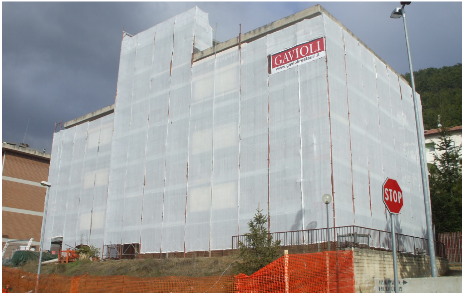
Il condominio "Gemma 84" durante i lavori di rafforzamento strutturale.
