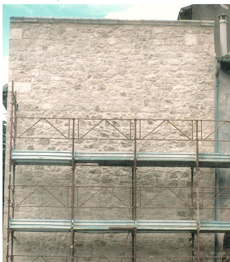
Le pareti esterne dopo il restauro.
