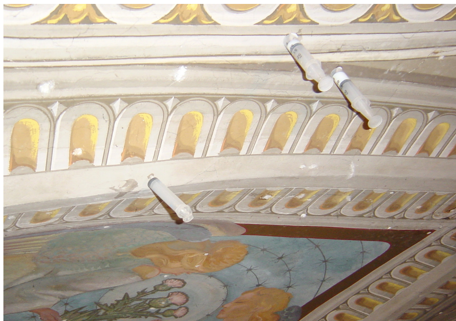
Particolare consolidamento intonaci della volta.
