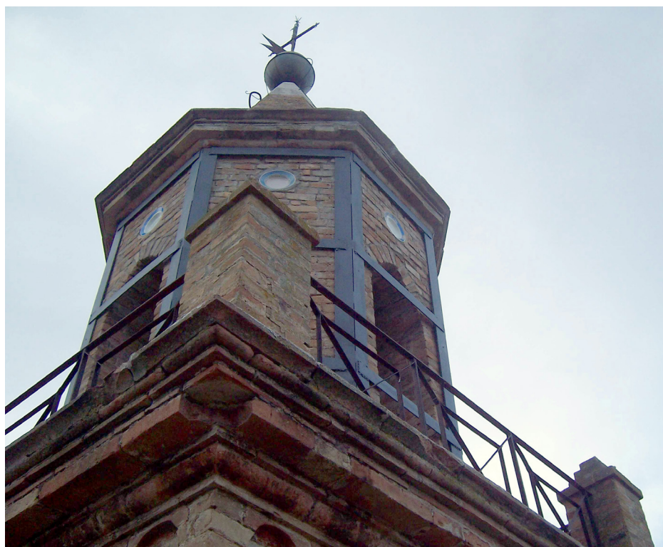
Messa in sicurezza del campanile.
