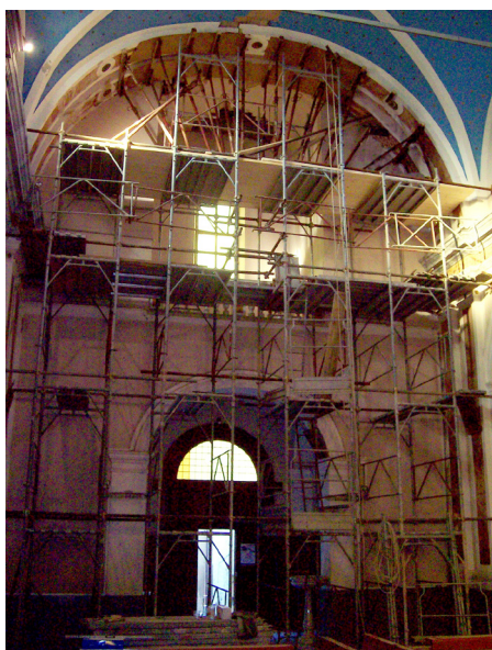
Intervento di messa in sicurezza.
