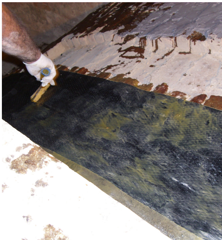
Interventi all'estradosso della volta con fasciature in fibra di carbonio.
