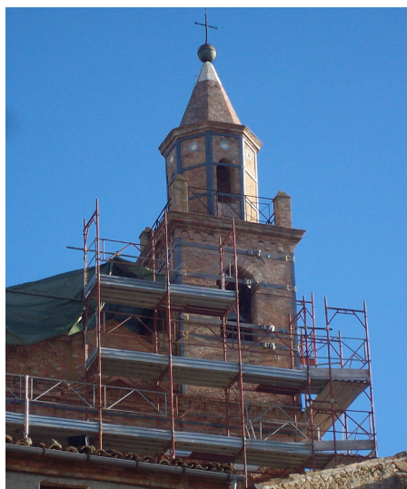
L'intervento sul campanile nella fase finale.
