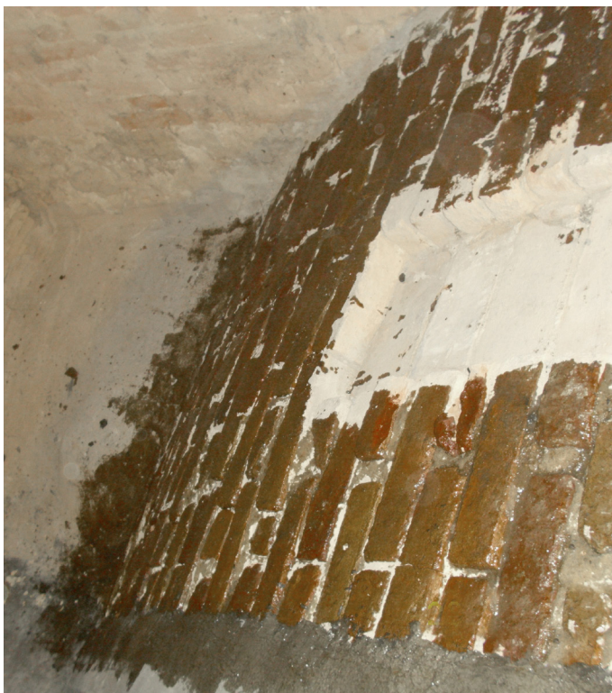
L'estradosso della volta prima delle fasciature in fibra di carbonio.
