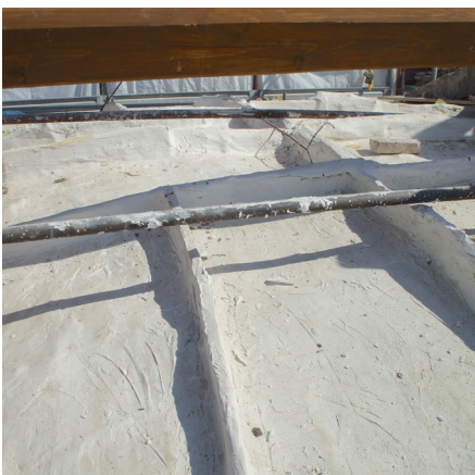
Estradosso della volta a fine del consolidamento.
