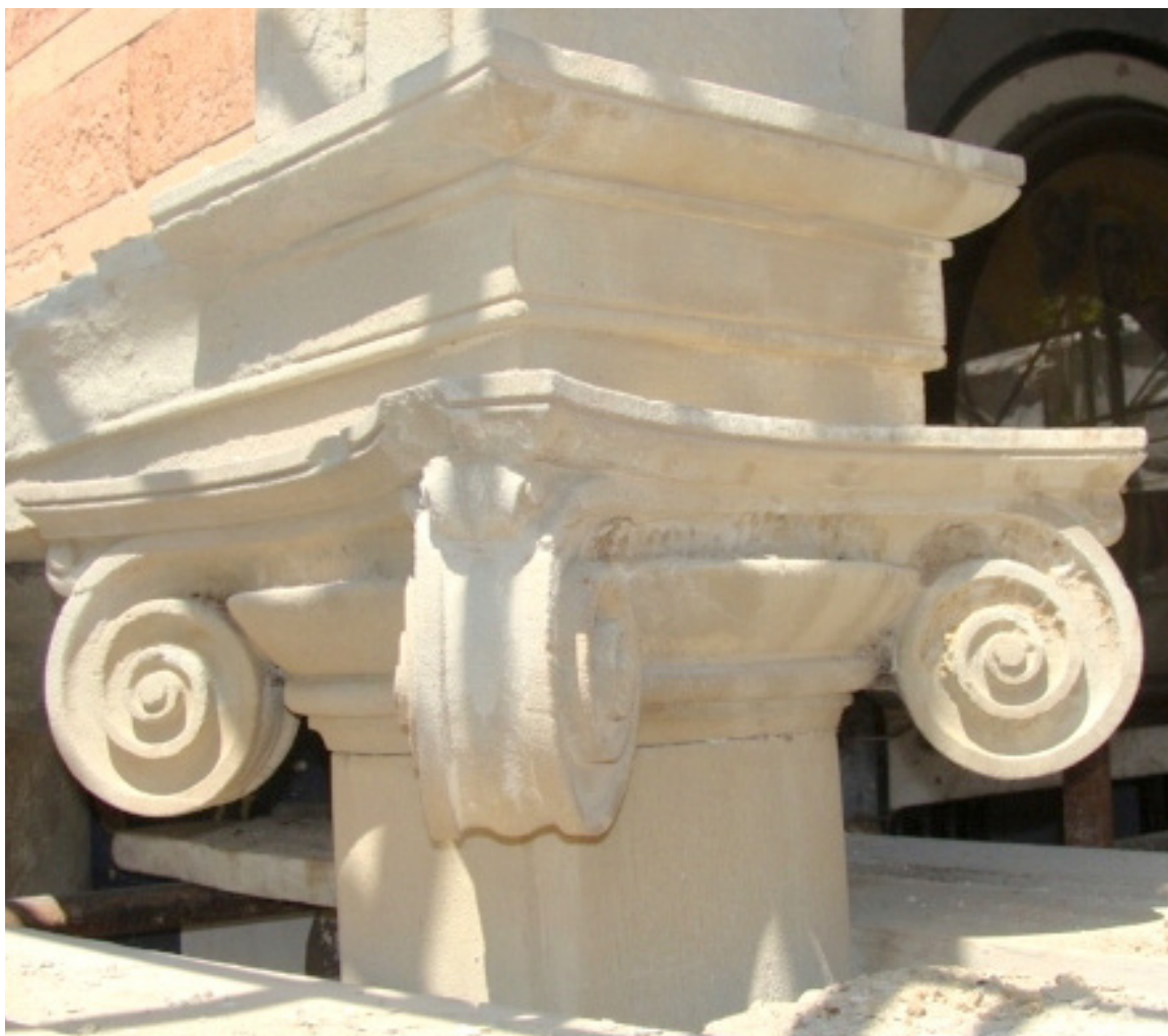
Restauro del capitello.
