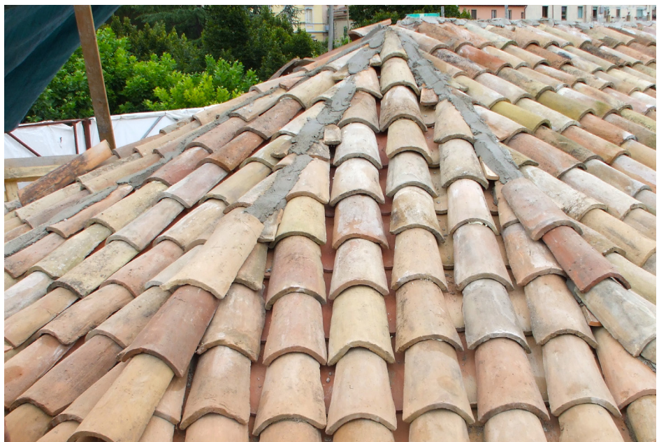
La copertura prossima all'ultimazione.
