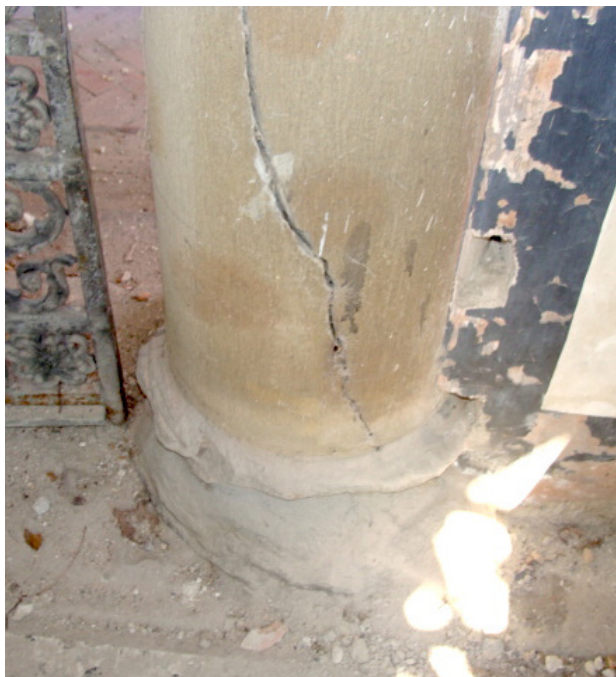
Prima della cerchiatura in acciaio.
