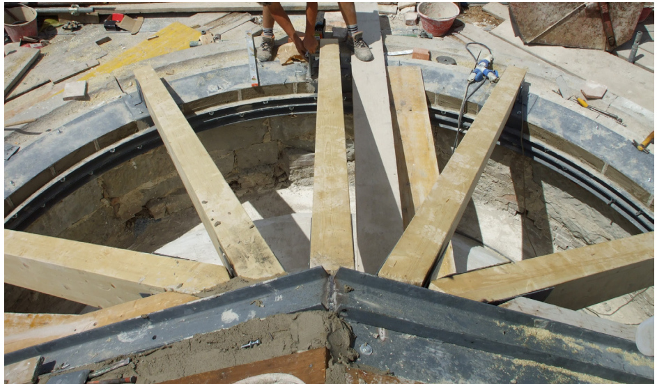
Costruzione della nuova copertura con cordoli in acciaio.
