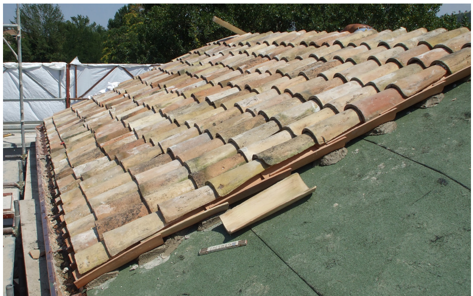
Messa in posa delle tegole.
