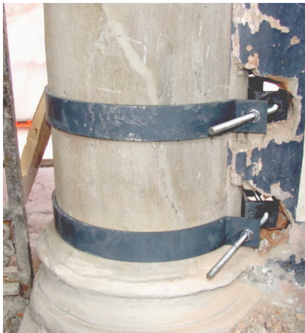
Cerchiatura in acciaio durante l'esecuzione.
