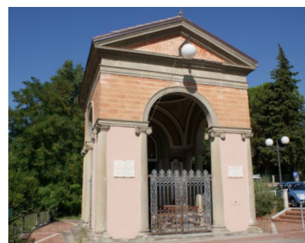
La cappella dopo i lavori.
