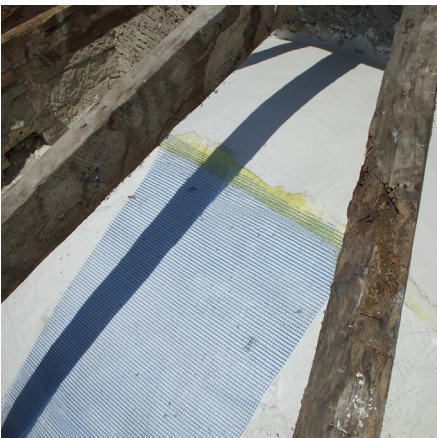
Estradosso della volta durante il consolidamento.
