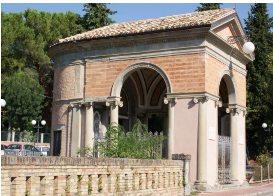
La cappella dopo i lavori.
