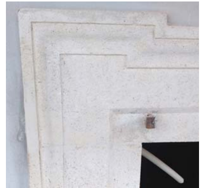
Cornice in pietra delle aperture a restauro ultimato.
