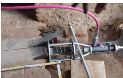
Il martinetto a prova conclusa ove è visibile l'estensione ottenuta.
