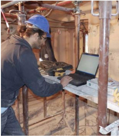
Fasi della prova di taglio diagonale sulla muratura.
