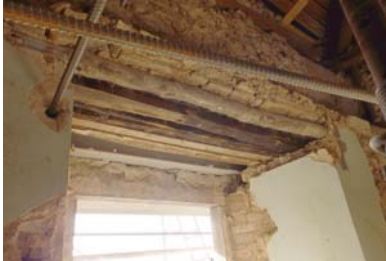
Architravi di finestra prima dei lavori.
