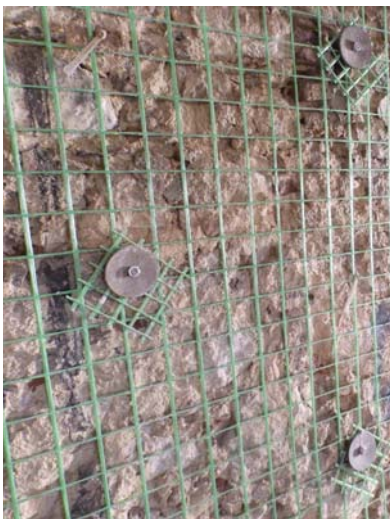
Intervento di placcaggio delle murature tramite applicazione di rete in FRP.
