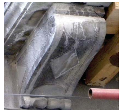
Prima dell'intervento di restauro.
