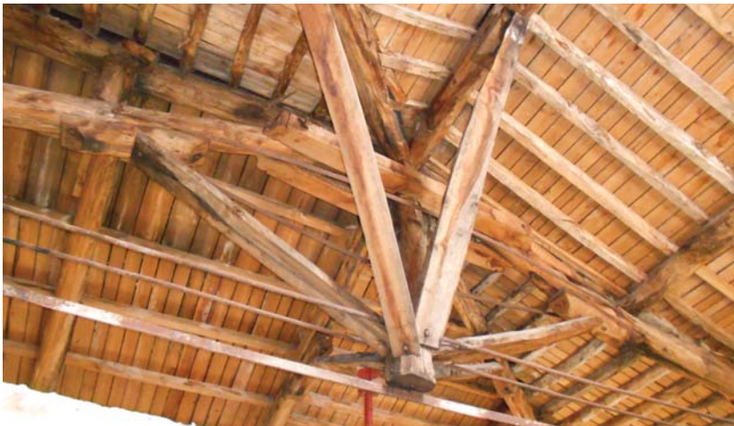
La copertura prima dei lavori.
