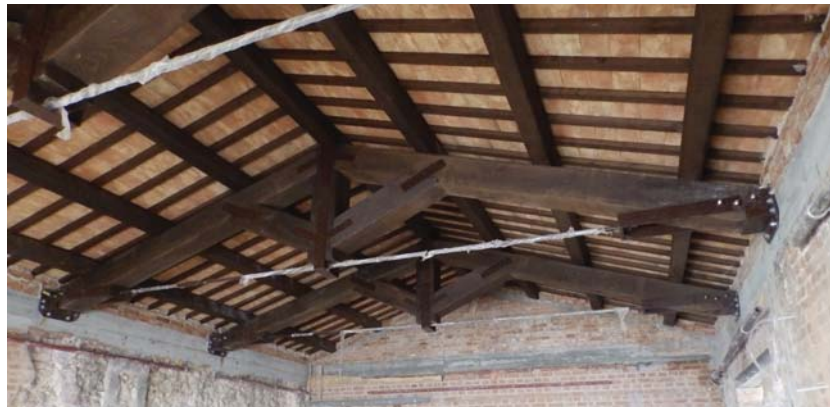
Una delle strutture di una copertura costituita da capriate e travi in legno massello di castagno e sovrastante pannellato durante i lavori.
