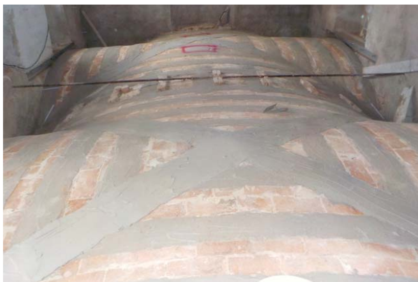
Realizzazione consolidamento volta a crociera mediante fasciatura con fibra di acciaio.
