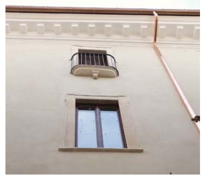
Tratto di facciata esterna dopo i lavori.
