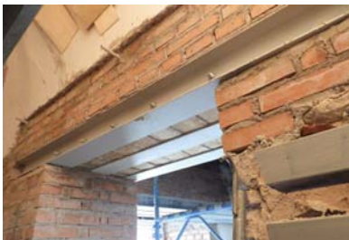
Architravi in acciaio dopo i lavori.
