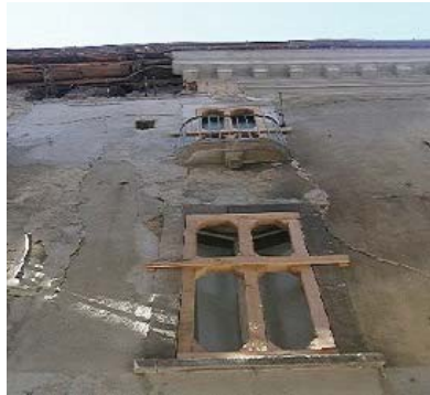
Tratto di facciata esterna prima dei lavori.
