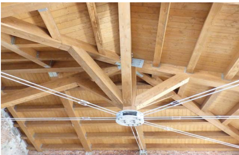
La copertura dopo i lavori.
