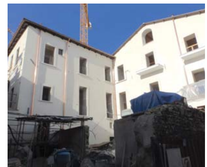
Due facciate esterne durante le fasi di ultimazione dei lavori.
