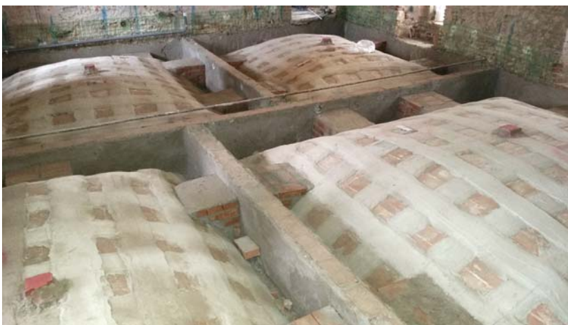
Ultimazione della fase di consolidamento estradossale delle volte.
