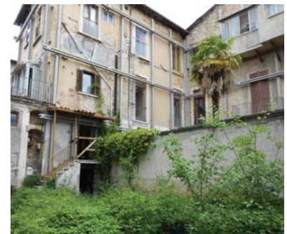
Due facciate esterne ante operam.
