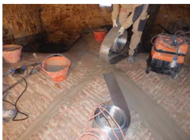
Fase di consolidamento estradossale volte con fibre di acciaio.
