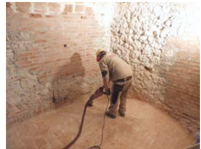
Svuotamento e pulizia estradossale della volta prima del consolidamento.
