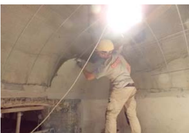
Realizzazione nuova volta alleggerita mediante modanatura eseguita con rete metallica e struttura portante in acciaio zincato.
