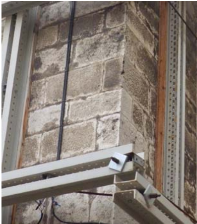
Angolata in pietra prima dell'intervento di consolidamento e restauro.
