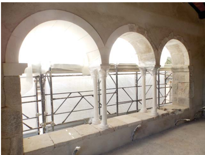
Il loggiato trecentesco, caratterizzato da tre archi ripartiti da una doppia fila di colonnine in pietra sovrastate da un capitello con elementi floreali, durante le ultime fasi di lavorazione.
