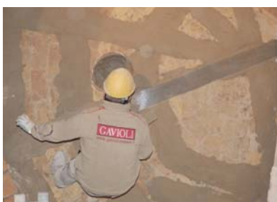
Ultimazione della fase di consolidamento estradossale volte.
