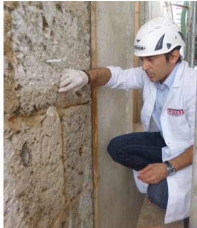
Fasi di consolidamento e restauro dell'angolata in pietra.
