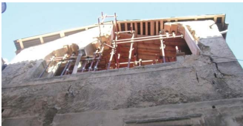
Facciata di Via Casella dove è posizionato il loggiato.
