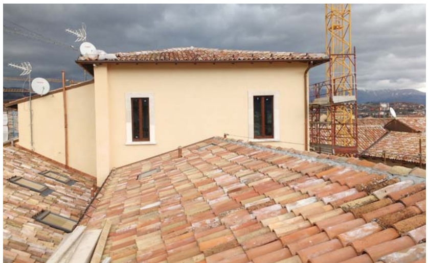
Porzione sommitale dell'aggregato successiva all'intervento di consolidamento e restauro.
