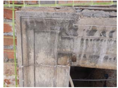
Cornice in pietra delle aperture prima del restauro.
