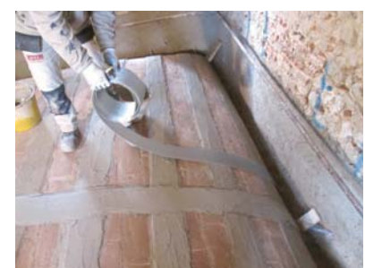
Fase di consolidamento estradossale della volta mediante fasciatura con fibra di acciaio.
