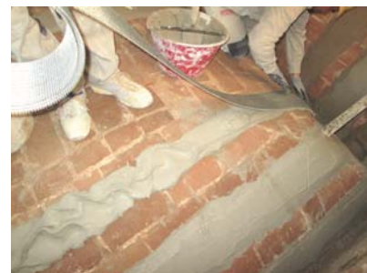
Realizzazione intervento di consolidamento estradossale della volta mediante fasciatura con fibra di acciaio.
