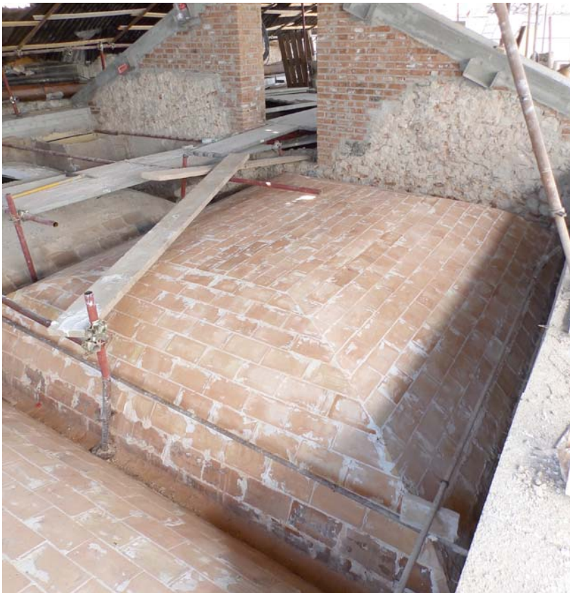
Fasi di ricostruzione di una volta crollata.
